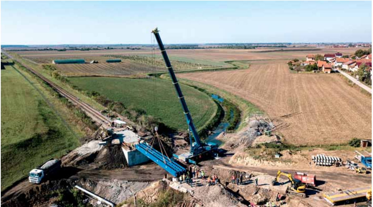
Postavljanje provizorija na mostu Bobotski kanal
