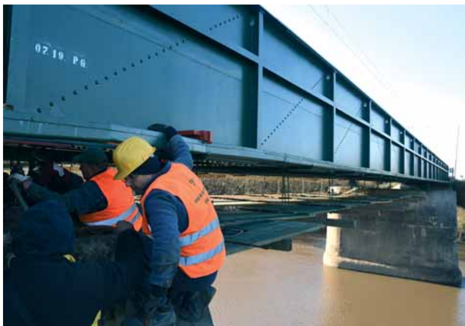
Demontaža dotrajalih ležajeva na mostu
