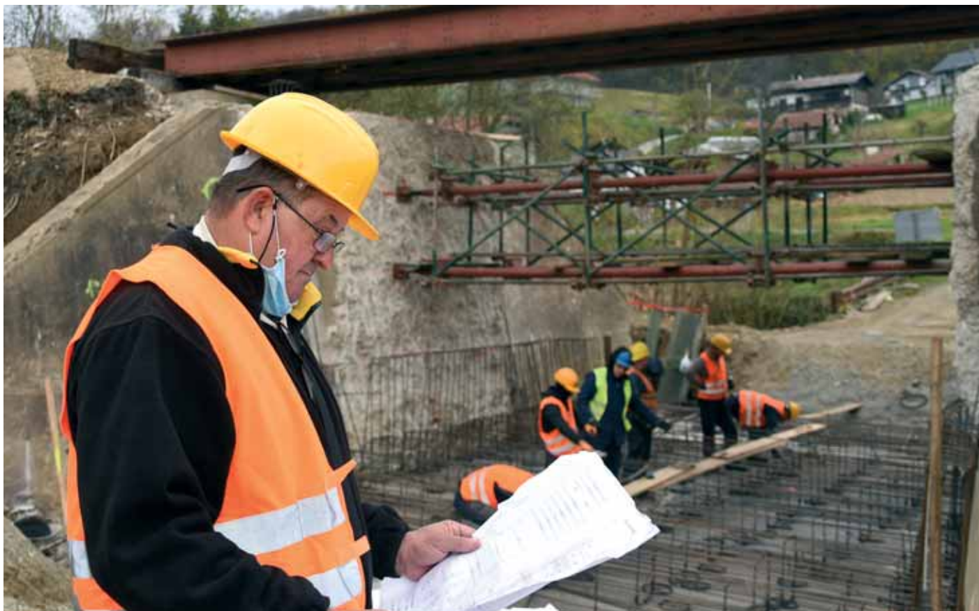
Šef gradilišta Tomo Rabuzin na rekonstrukciji nadvožnjaka kod Đurmanca
