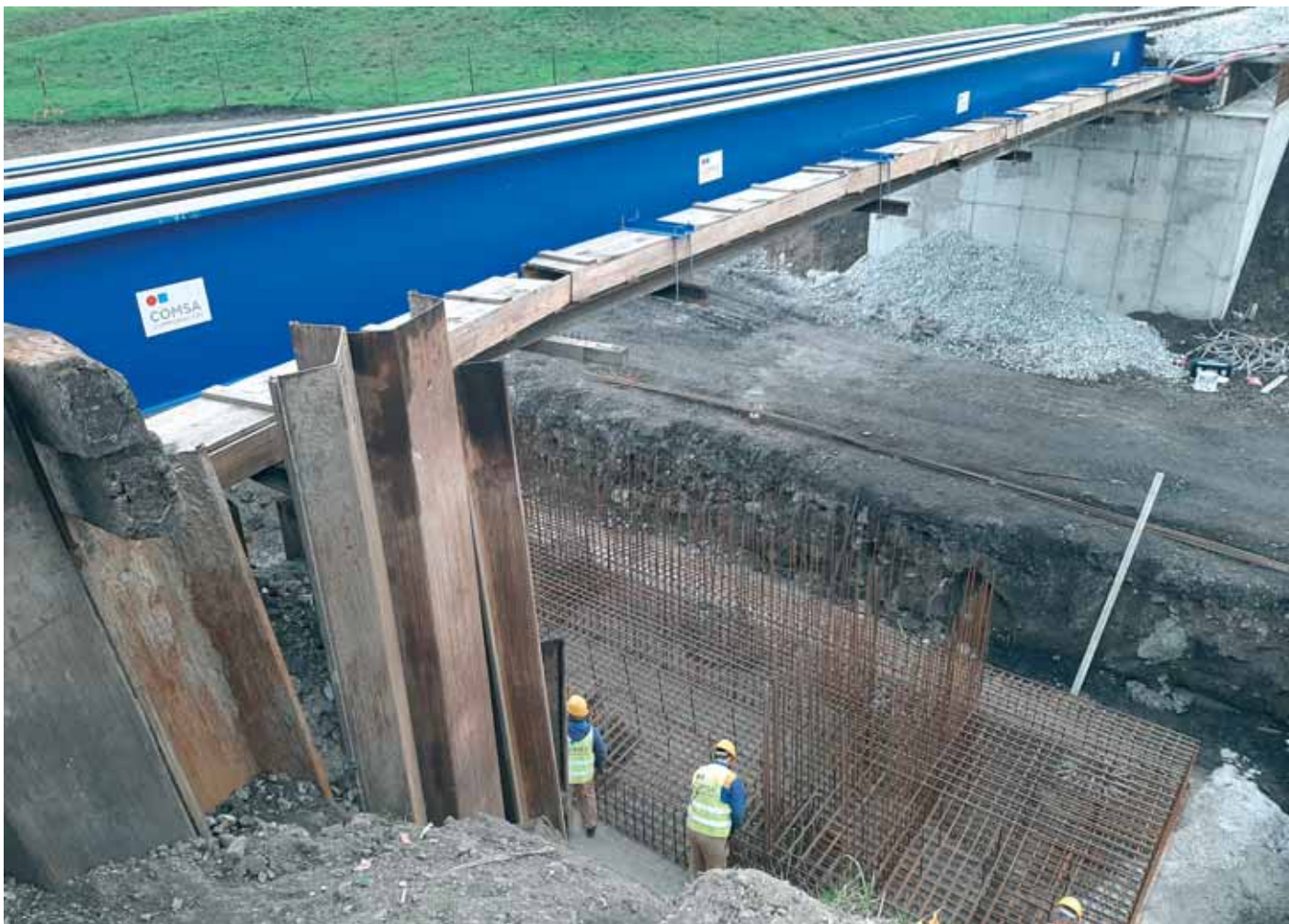
Radovi na izgradnji upornjaka mosta Bobotski kanal
