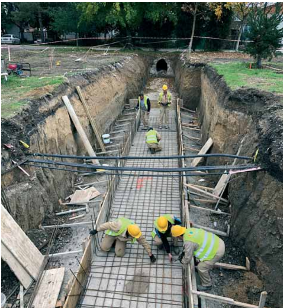
Radovi na propustu u Nuštru
