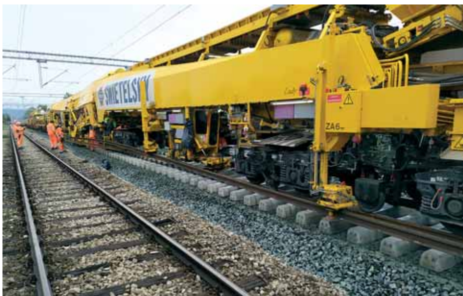
Radovi na izmjeni kolosijeka
