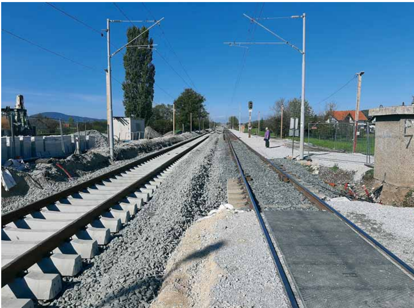
Radovi u stajališu Brdovec
