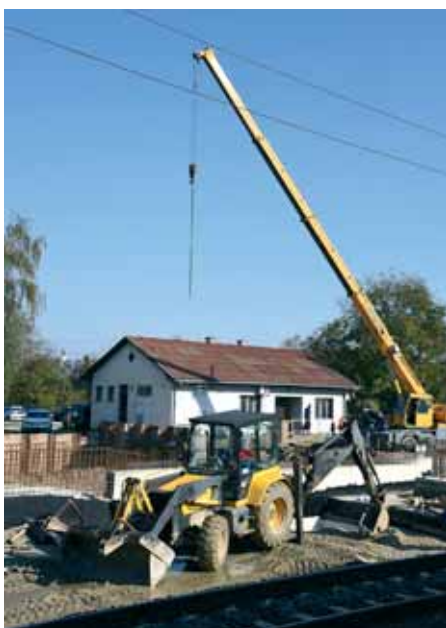
Izgradnja pothodnika u Vrbovcu
