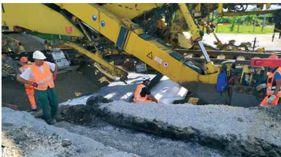
Radovi na zamjeni zaštitnog sloja
