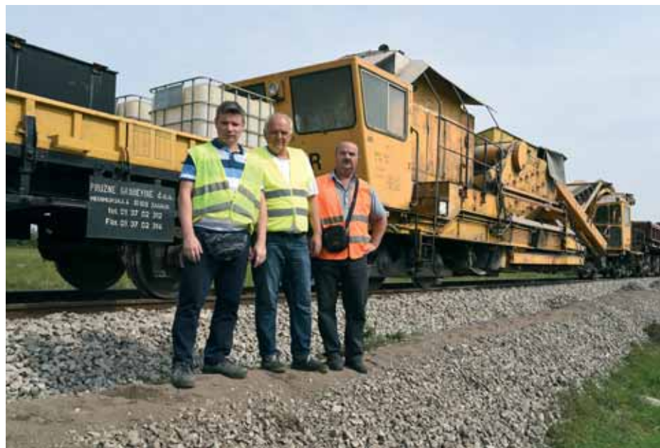
Glavni šefovi na gradilištu remonta pruge Čakovec – Mala Subotica, Krešimir Sertić, Ivo Mamuzić i Novo Kojadinović
