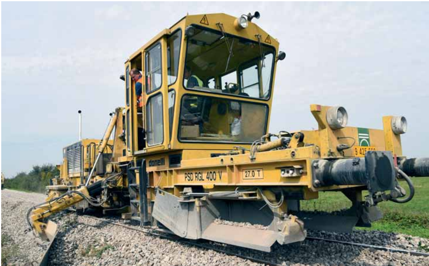
Zgrtanje tucanika specijalnim strojem na pruzi Čakovec - Mala Subotica
