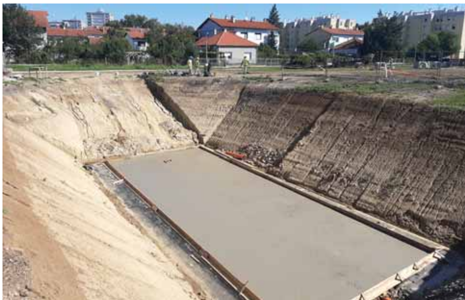
Betonirana ploča pothodnika u Vukovar Borovu Naselju
