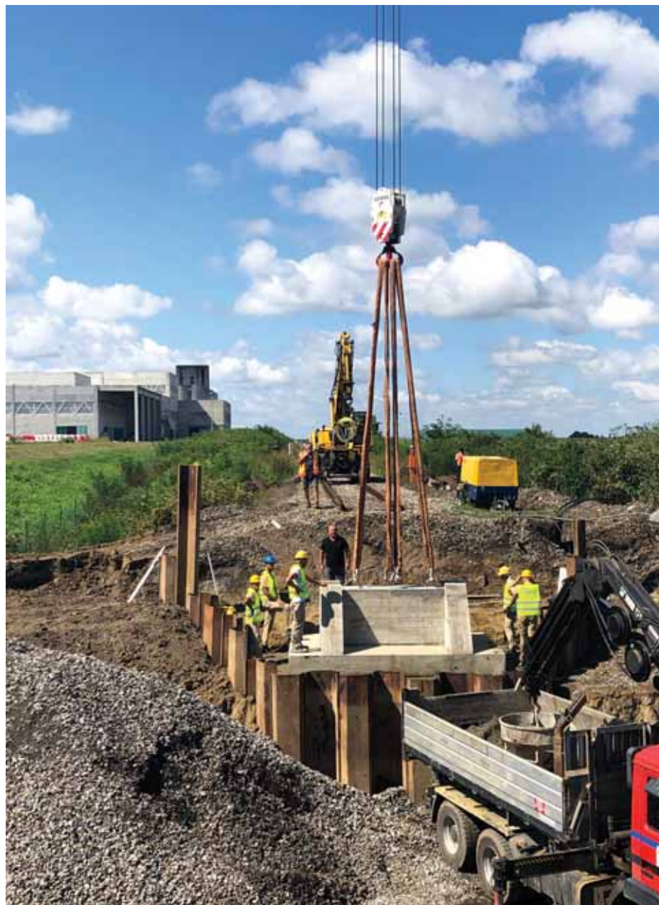
Temelj za postavljanje provizorija mosta Bobotski kanal
