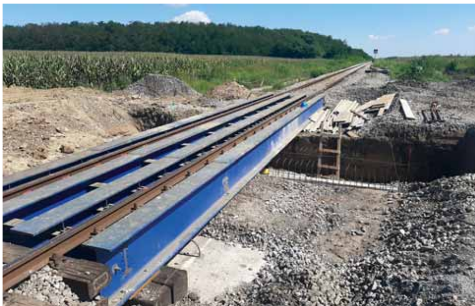
Postavljen provizorij na propustu
