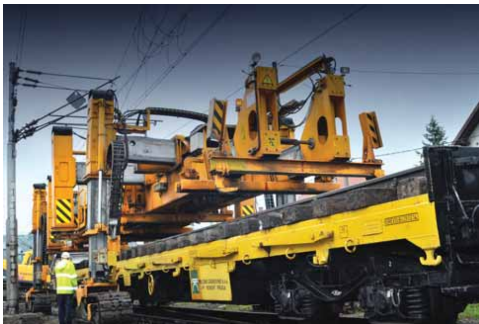
Spuštanje starog kolosijeka na vagon
