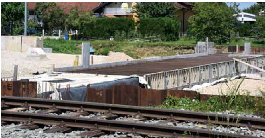
Betonska konstrukcija budućeg podvožnjaka u Zaprešiću
