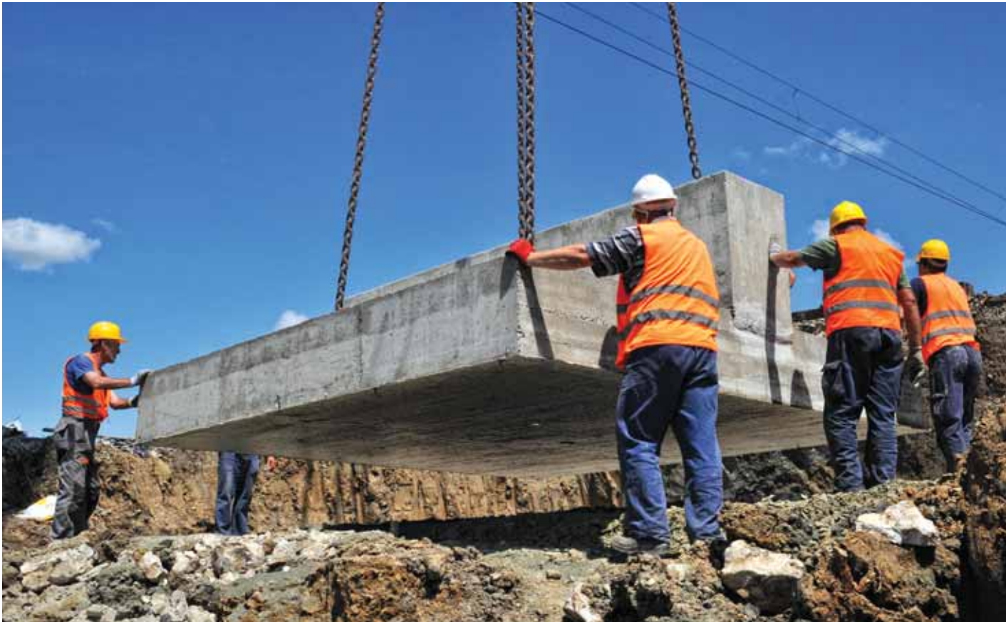
Postavljanje armirano betonskog oslonca
