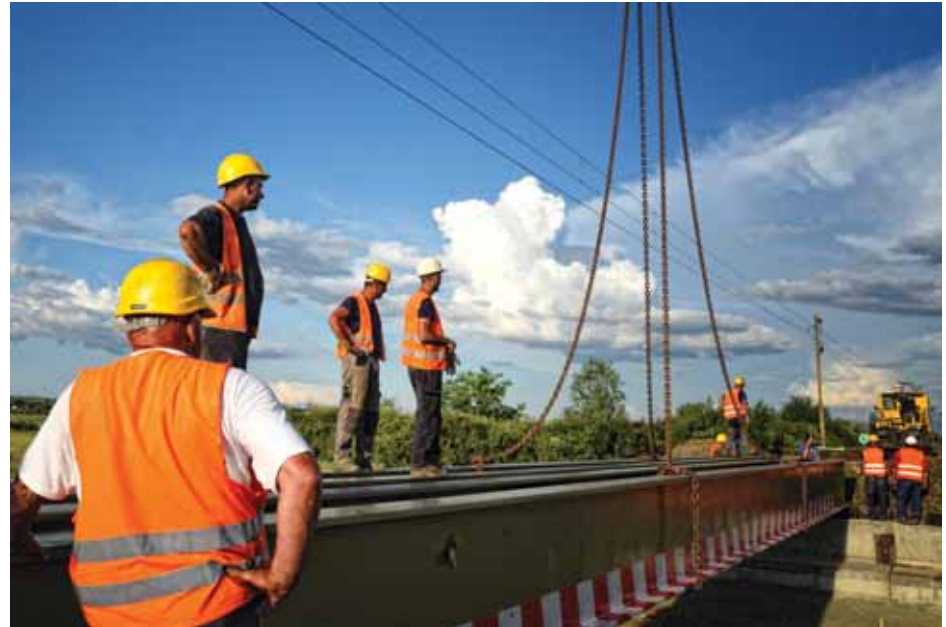
Provizorij na ležištu budućeg propusta
