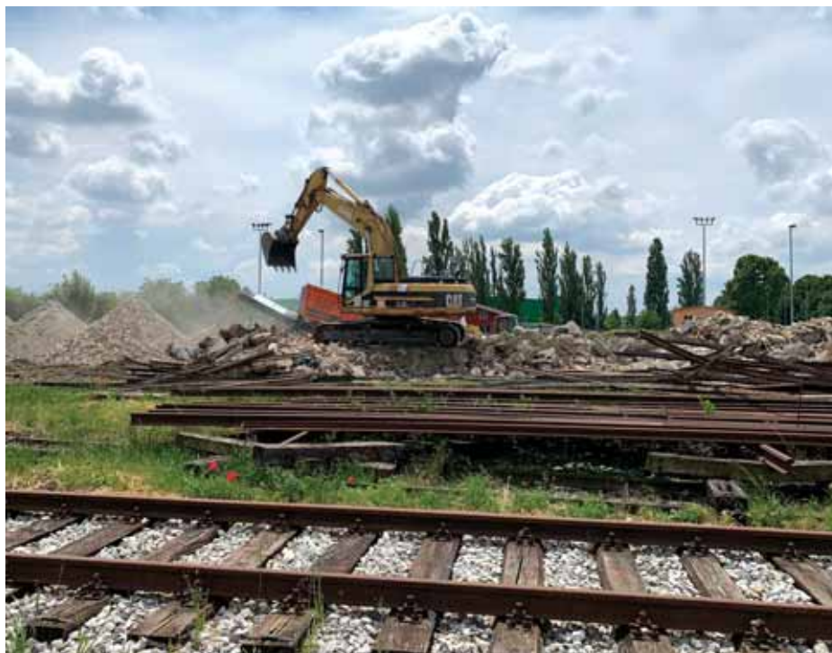
Uklanjanje građevina u kolodvoru Vukovar-Borovo Naselje i priprema terena
