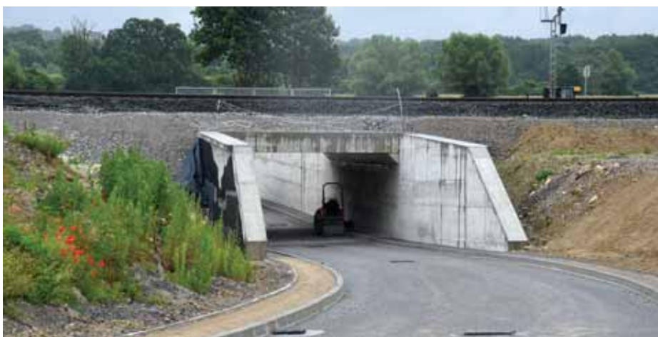
Podvožnjak - pred asfaltiranje, Križevci
