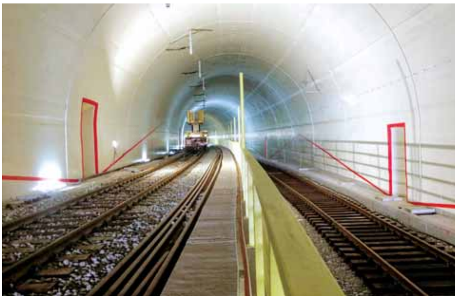
Završni radovi u tunelu
