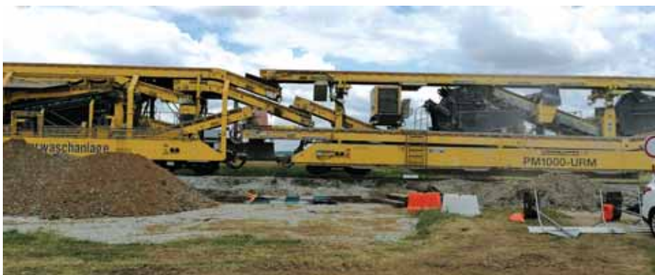
Radovi na obnovi pruge od Virovitice do Pitomače
