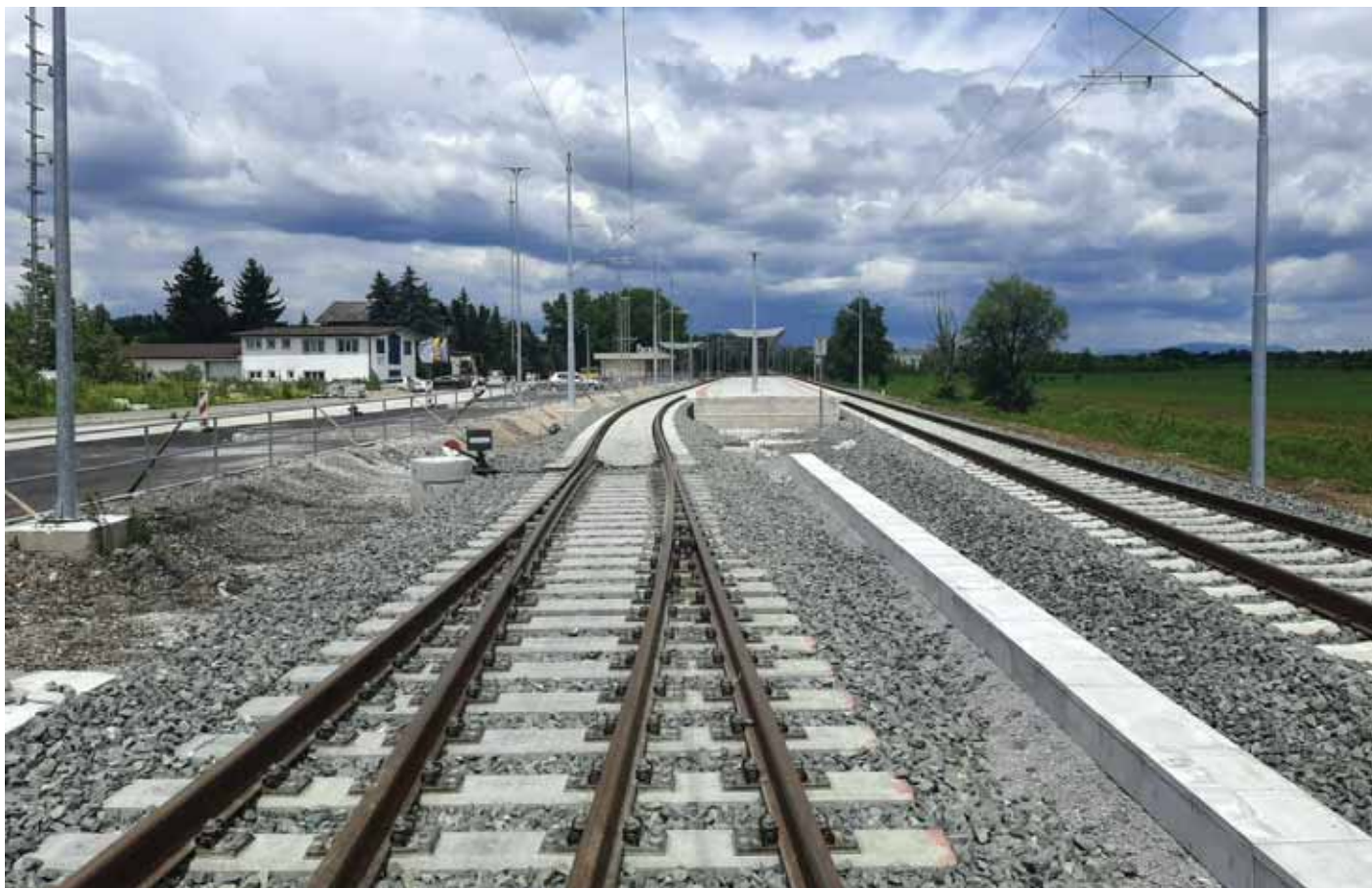
Radovi na projektu modernizacije i elektrifikacije pruge Zaprešić – Zabok
