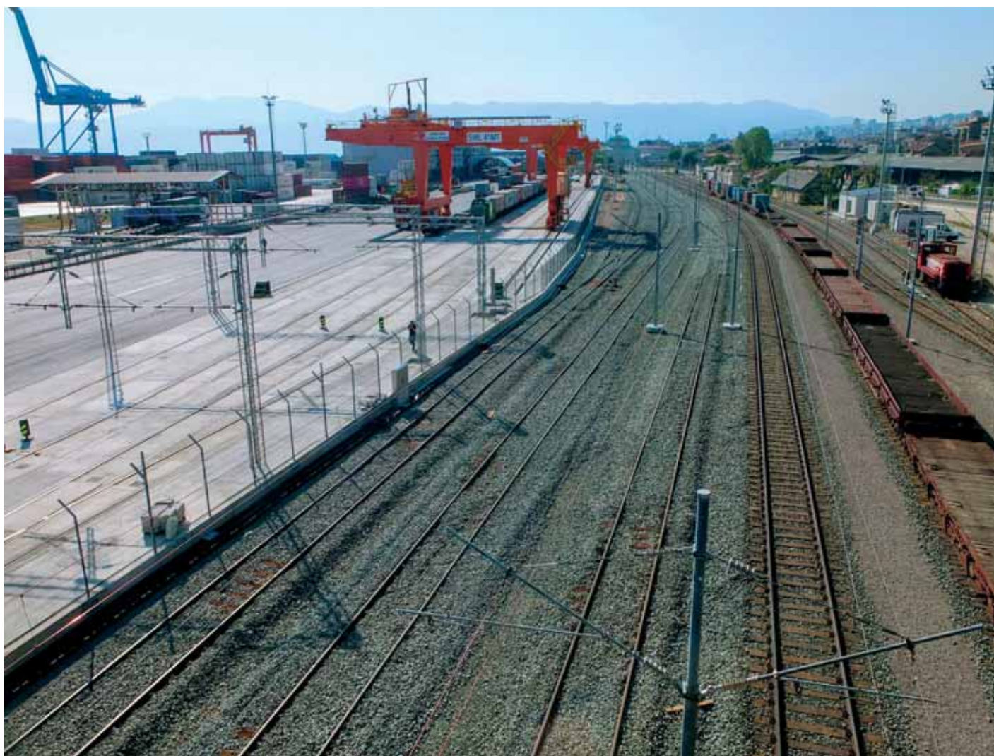
Obnovljeni kolosijeci u kolodvoru Brajdica
