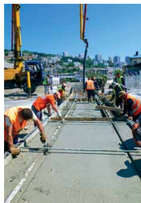
Radovi na kolosijeku prema delti
