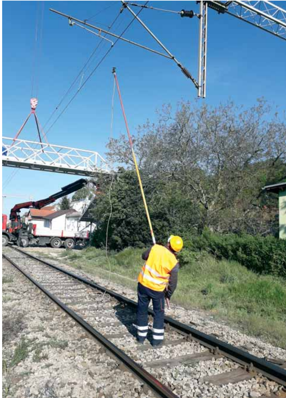
Zamjenik voditelja dionice KM Zagreb postavlja motku za uzemljenje
