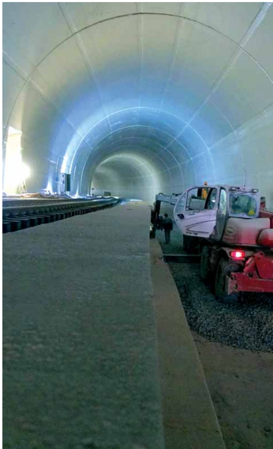
Radovi u tunelu
