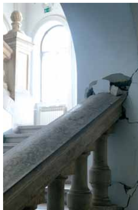
Središnje stubište u upravnoj zgradi
