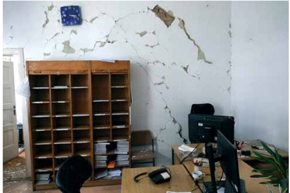
Ured u upravnoj zgradi HŽ Infrastrukture
