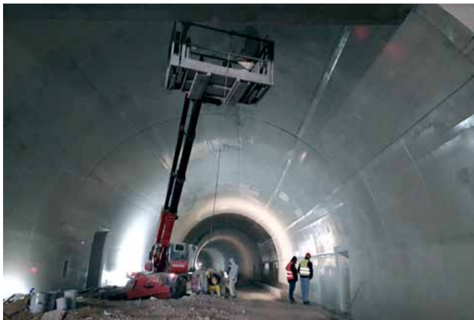
Završni radovi u tunelu u sklopu projekta Rijeka Brajdica
