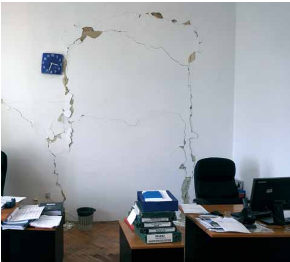
Ured u upravnoj zgradi HŽ Infrastrukture
