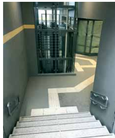
Dizalo u novom pothodniku
