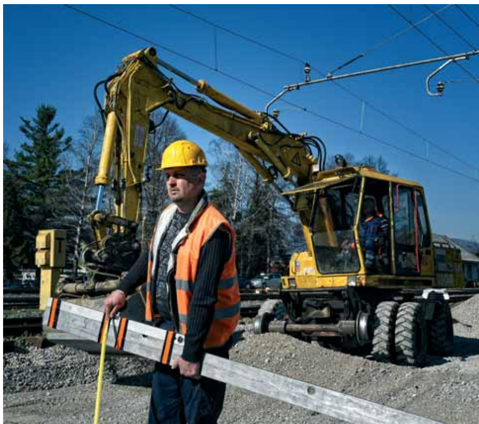
Mjerenje visine tamponskog sloja
