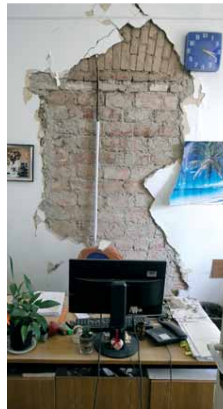
Ured u upravnoj zgradi HŽ Infrastrukture
