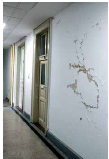
Hodnik u upravnoj zgradi HŽ Infrastrukture
