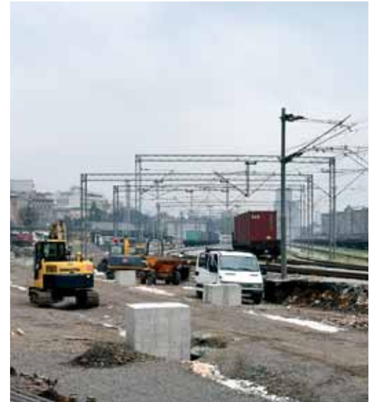
Radovi na rekonstrukciji prvih šest kolosijeka u kolodvoru Mlaka
