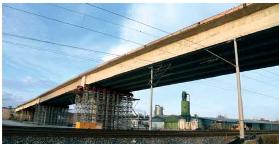
Nadvožnjak na ulazu u kolodvor Dugo Selo
