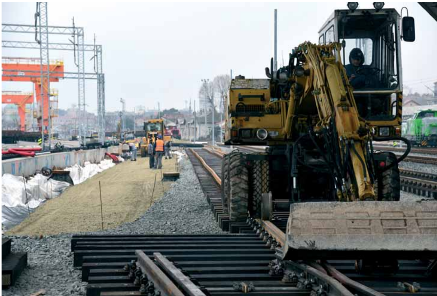
Radovi na izgradnji preostalih kolosijeka u kolodvoru
