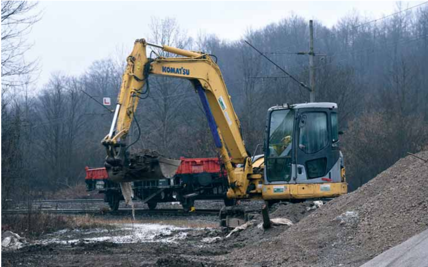
S gradilišta u Oštarijama
