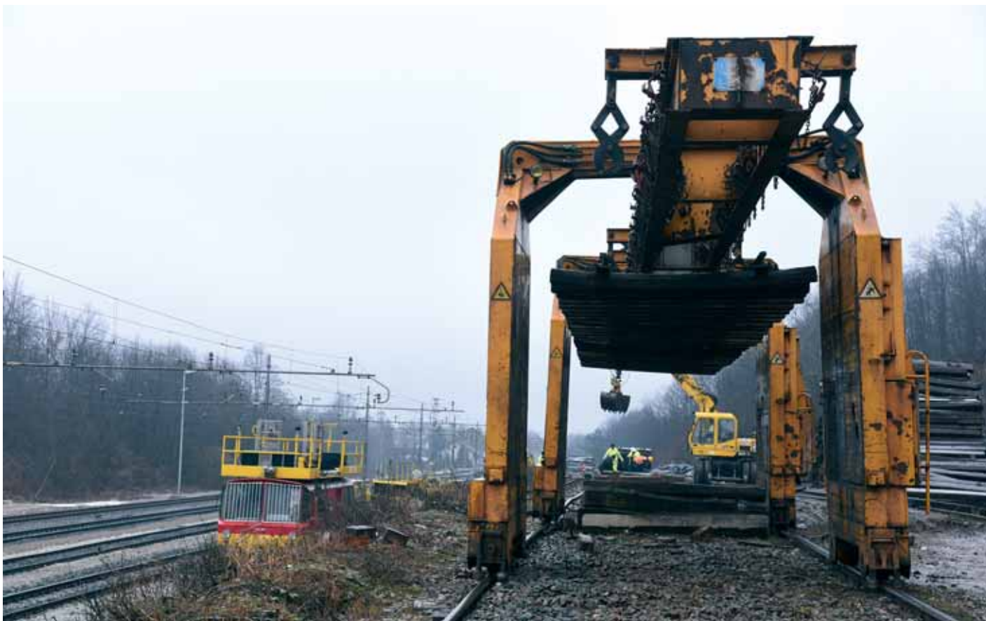
S gradilišta u Oštarijama
