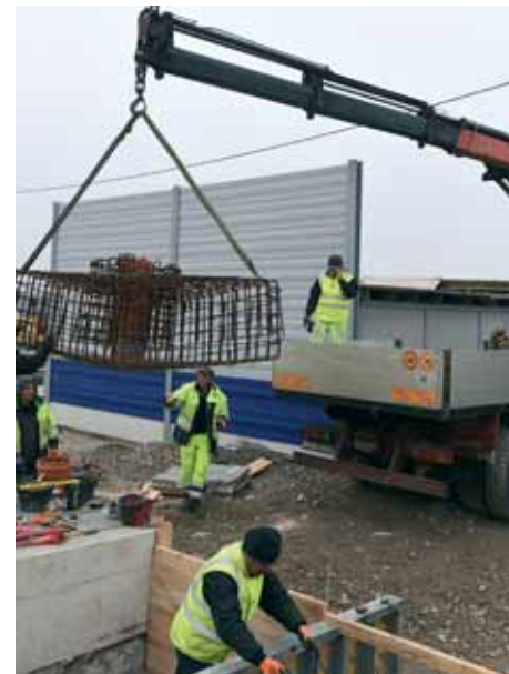
Radovi u stajalištu Gradec
