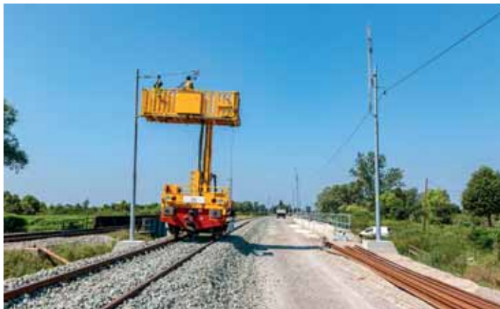
Montaža kontaktne mreže
