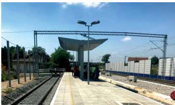
Novo stajalište u kolodvoru Gradec
