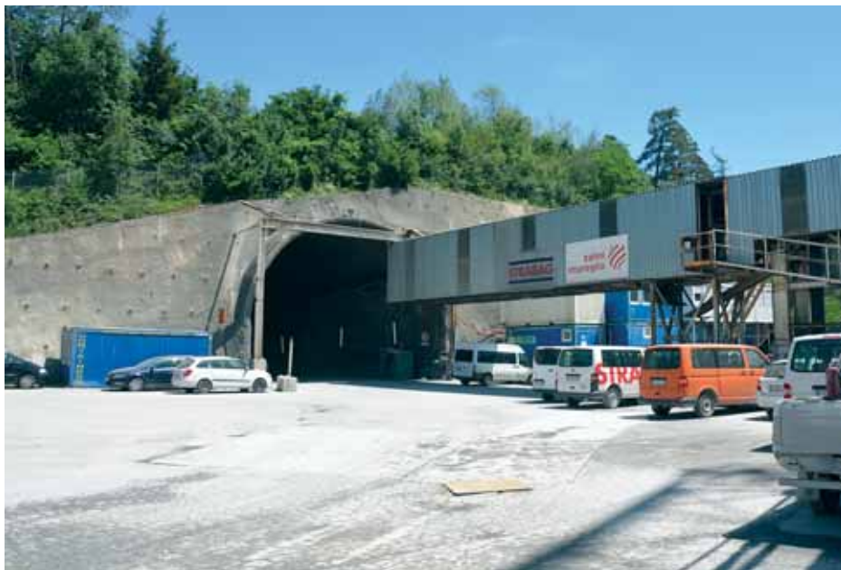
Prilazni tunel na gradilištu Arental
