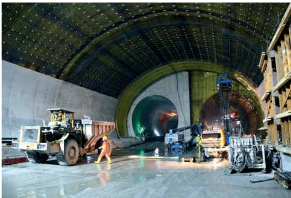
Gradilište baznoga tunela Brenner na lokaciji Arental u blizini Innsbrucka
