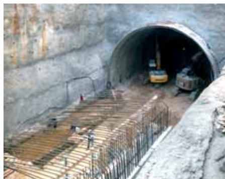
Spoj tunela Sušak s portalnom građevinom
