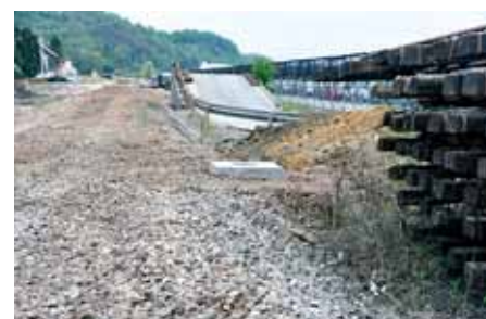
Dio rampe za istovar u kolodvoru Luka
