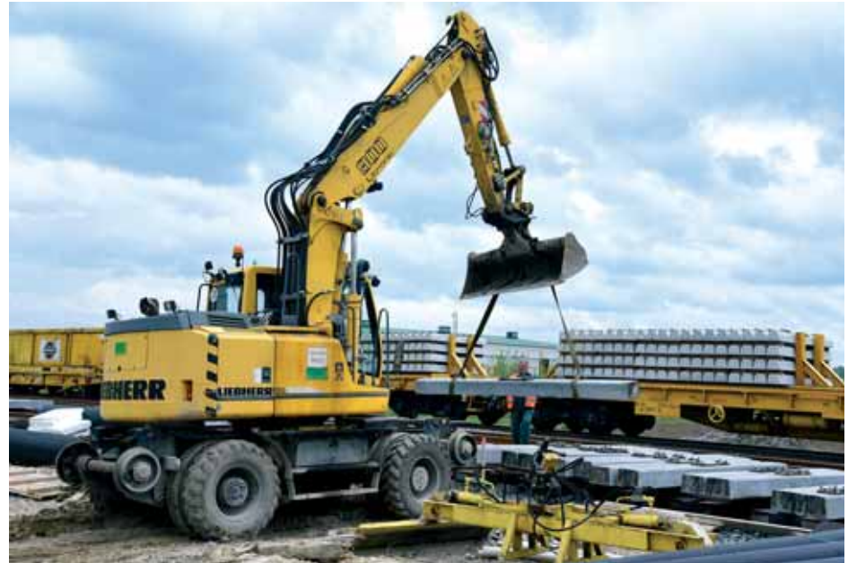
Radovi u kolodvoru Novi Dvori
