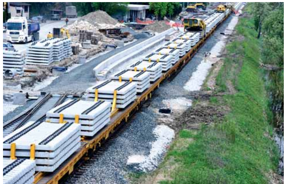
Postrojenje tvrtke Swietelsky za izmjenu pragova u Novim Dvorima
