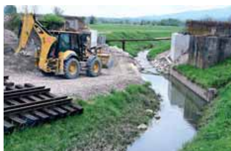
Radovi na mostu Vučerna
