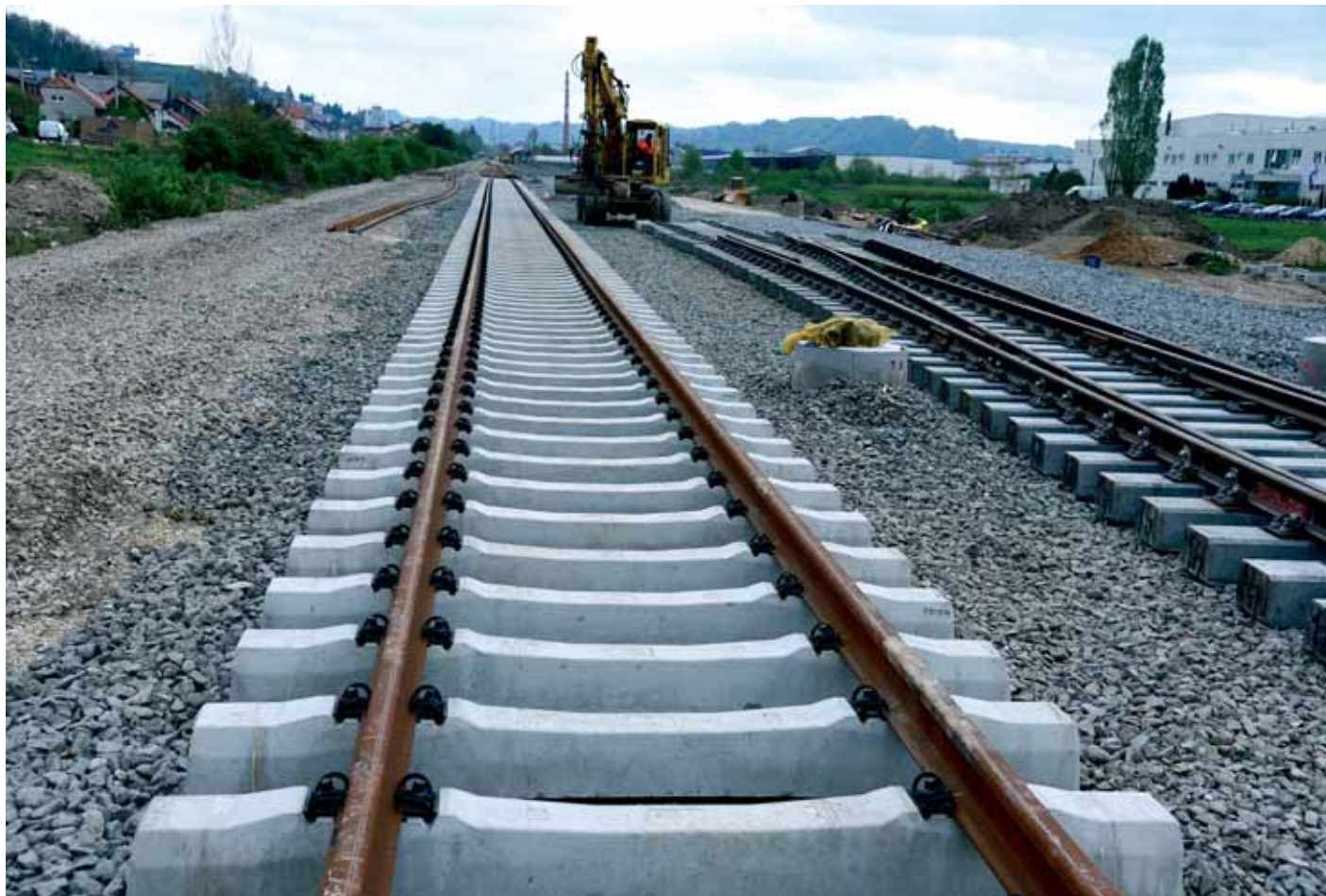
Radovi na izmještenom kolodvoru Zabok TK
