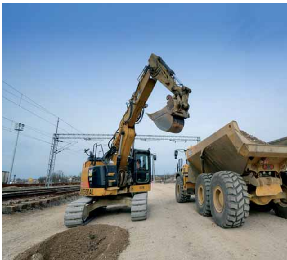
Završni radovi na donjemu pružnom ustroju na 5. i 6. kolosijeku
