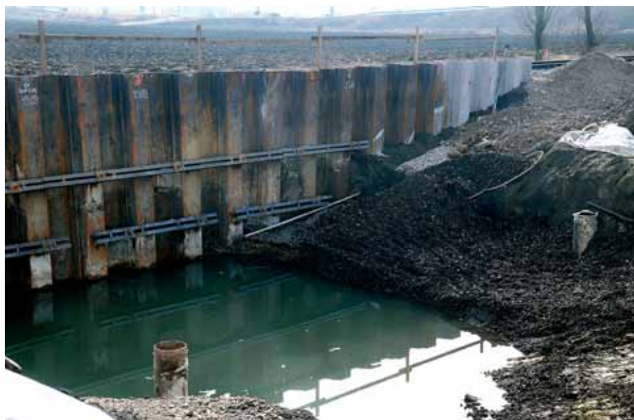
Iskop građevne jame za pothodnik u kolodvoru Novi Dvori
