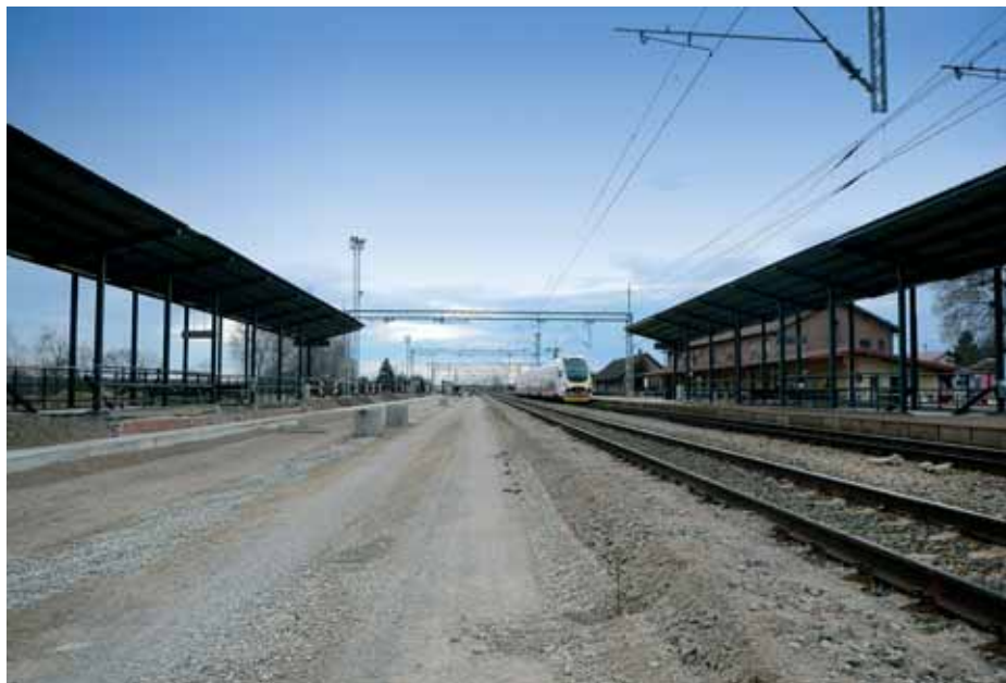
Završni radovi na donjemu pružnom ustroju na 5. i 6. kolosijeku
