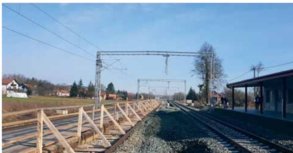
Privremeni peron u kolodvoru Gradec
