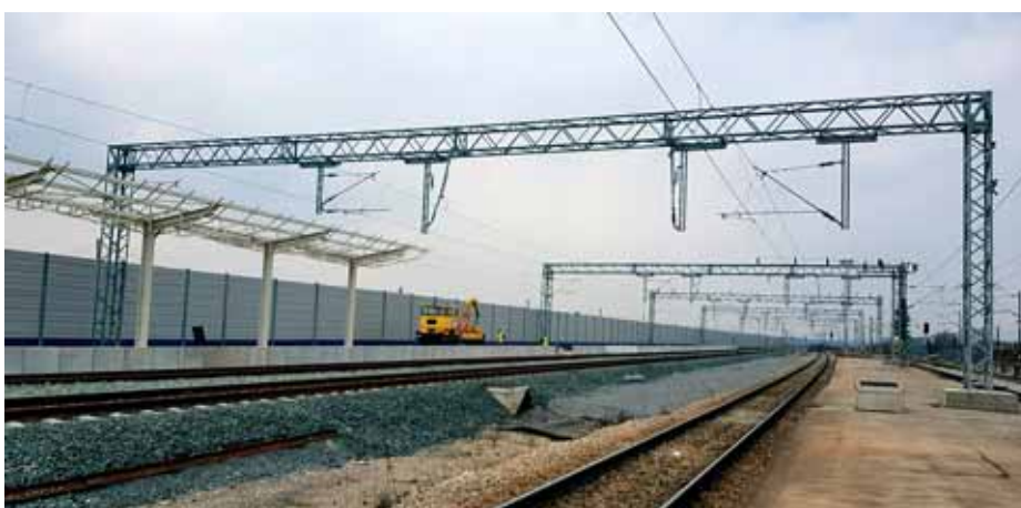
Radovi na gradnji perona i nadstrešnica u kolodvoru Vrbovec
