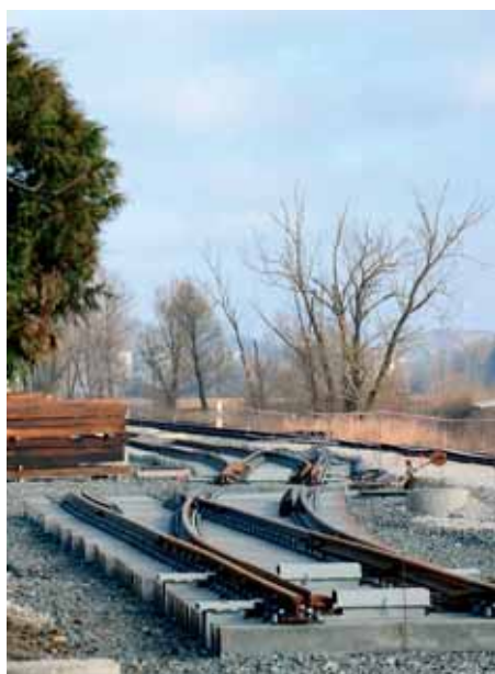
Položena nova skretnica u kolodvoru Novi Dvori
