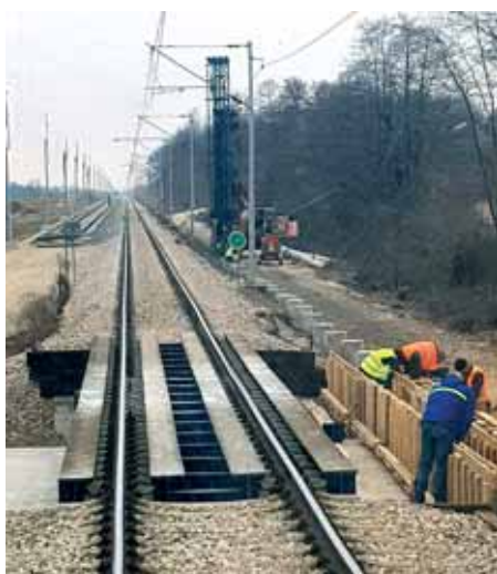
Provizorij na mostu Petrovina
