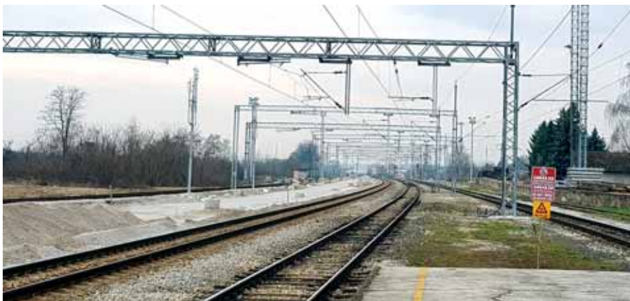
Radovi na donjem ustroju u kolodvoru Križevci
