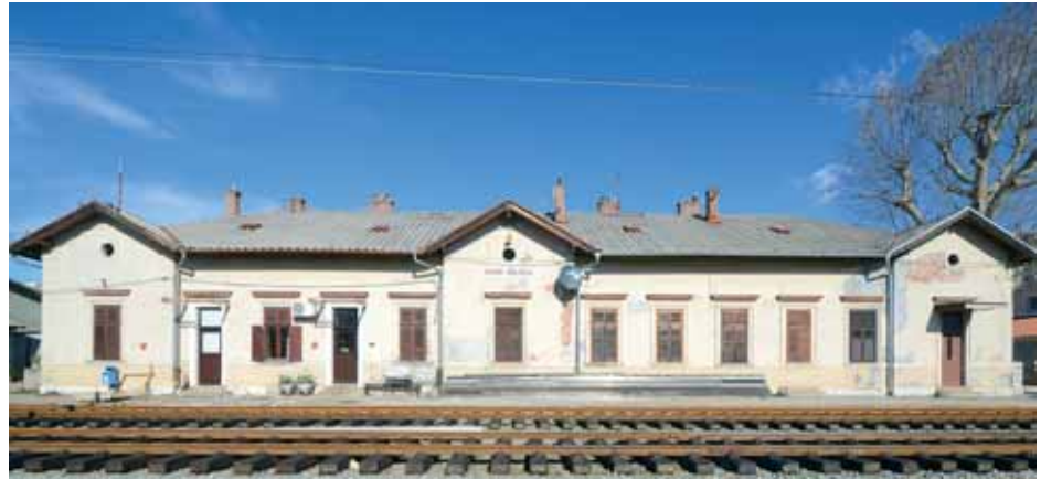
Novi kolosijeci ispred kolodvora Rijeka Brajdica
