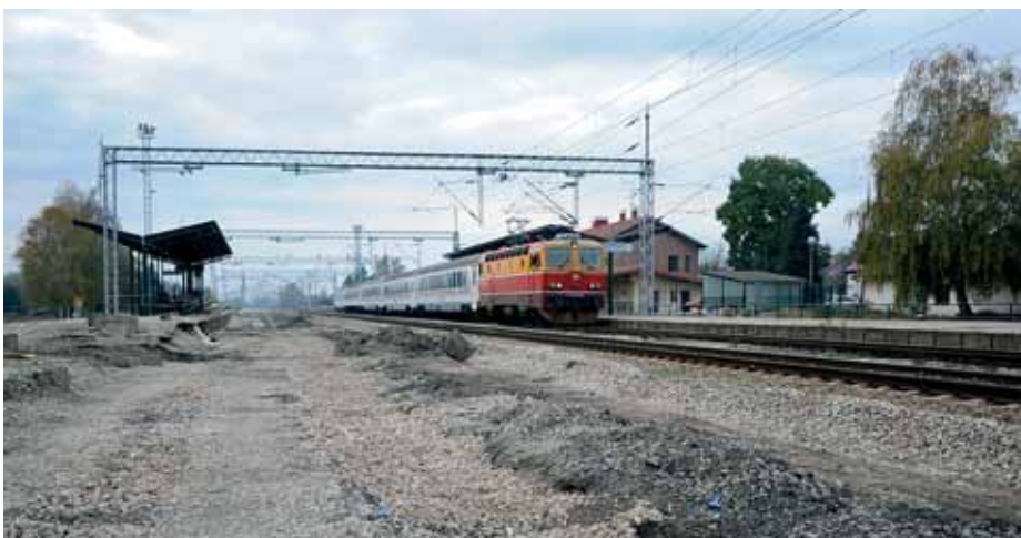
Obilazak gradilišta u kolodvoru Križevci
