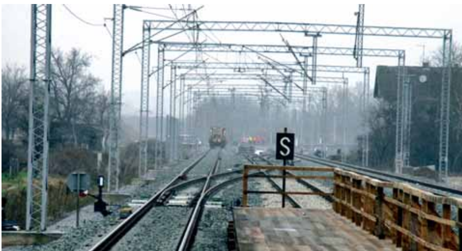
Obilazak gradilišta u kolodvoru Gradec
