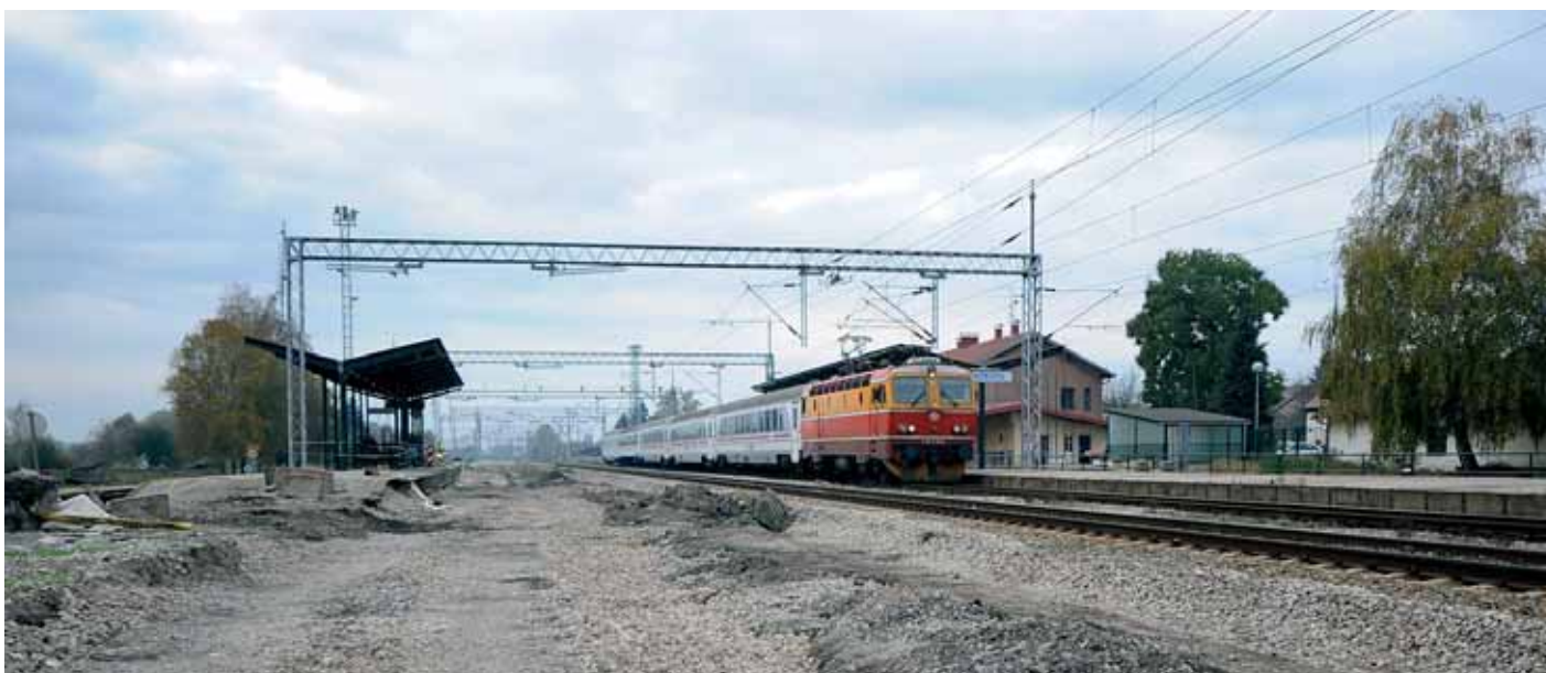
Izrada donjeg ustroja u kolodvoru Križevci
