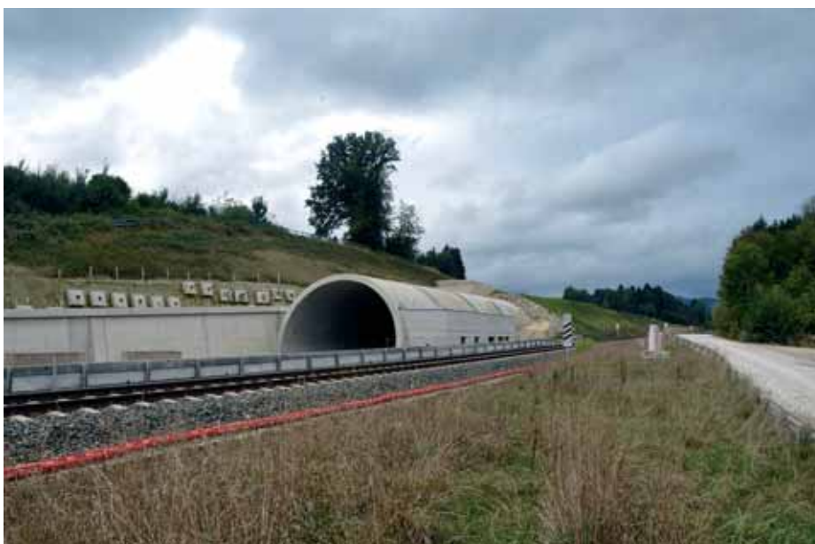
Istočni portal novog tunela Stein
