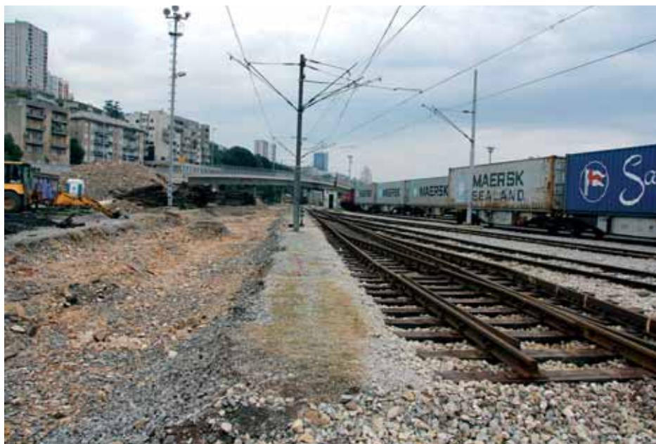
Radovi na projektu
