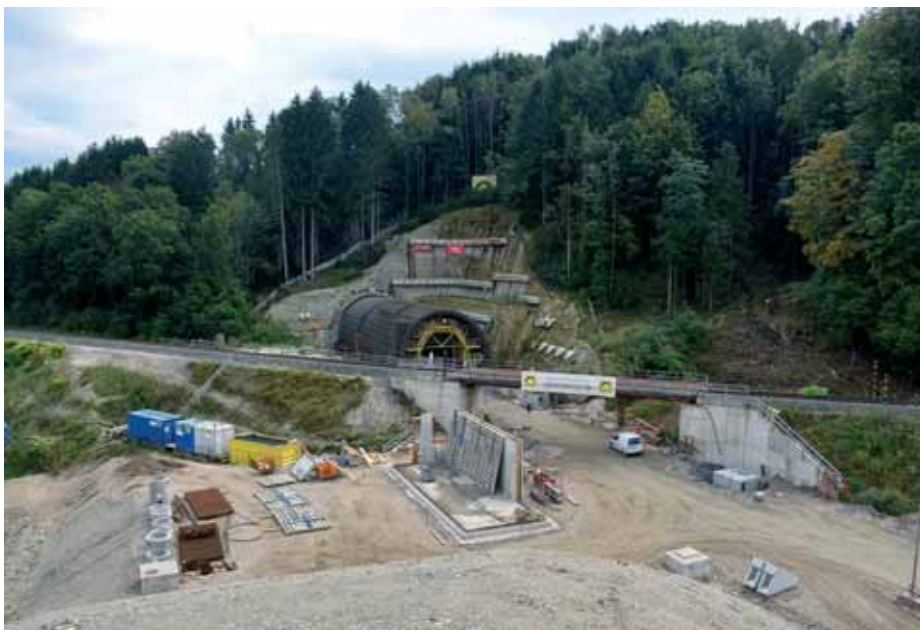
Zapadni portal tunela Stein
