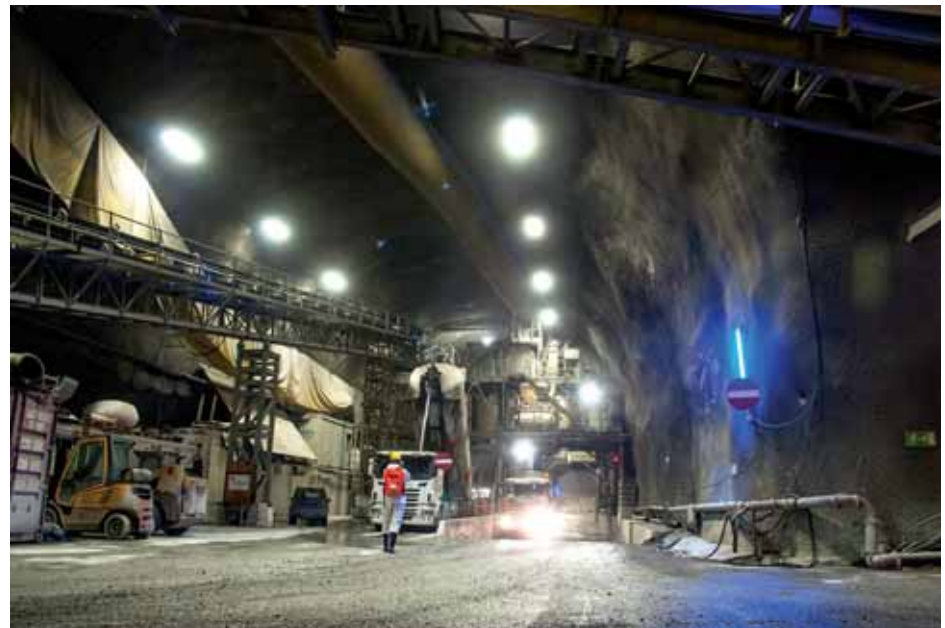
Unutrašnjost tunela Ceneri tijekom izgradnje 2016.
