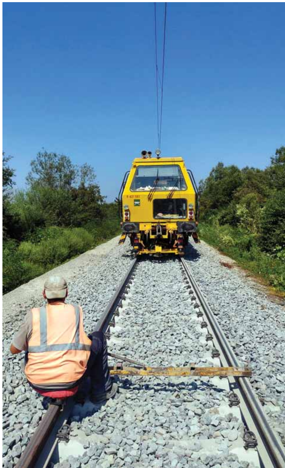
Remont na dionici Greda - Sisak
