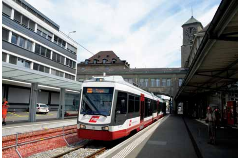
Novi kolodvor u izgradnji u St. Gallenu
