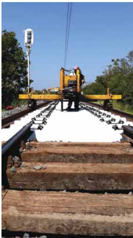
Polaganje novog kolosijeka na betonskim pragovima
