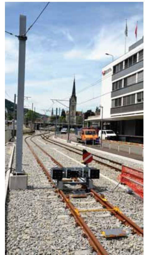
Novi kolodvor u izgradnji u St. Gallenu
