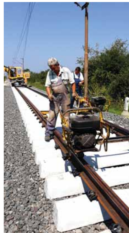
Pričvršćivanje novih tračnica
