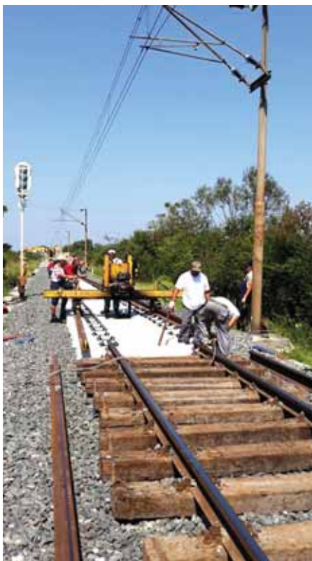
Spoj novog i postojećeg kolosijeka
