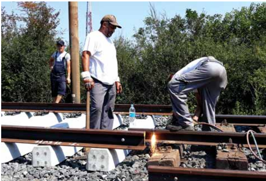
Izrada tračničkih sastava
