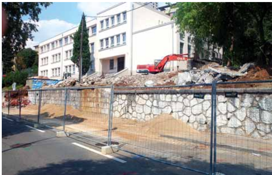
Radovi u ulici Šetalište XIII. divizije
