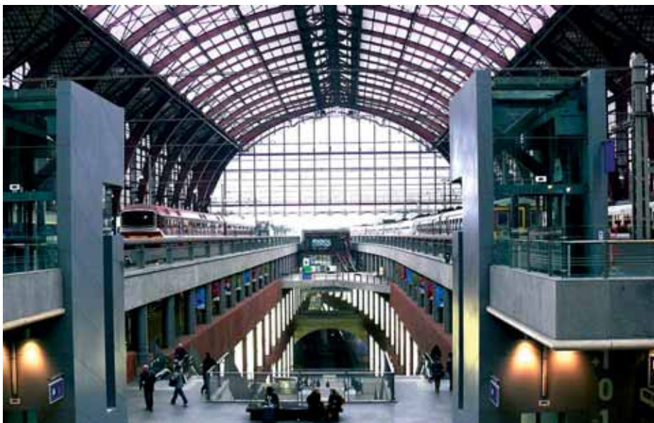
Čelična konstrukcija i peroni unutar kolodvora
