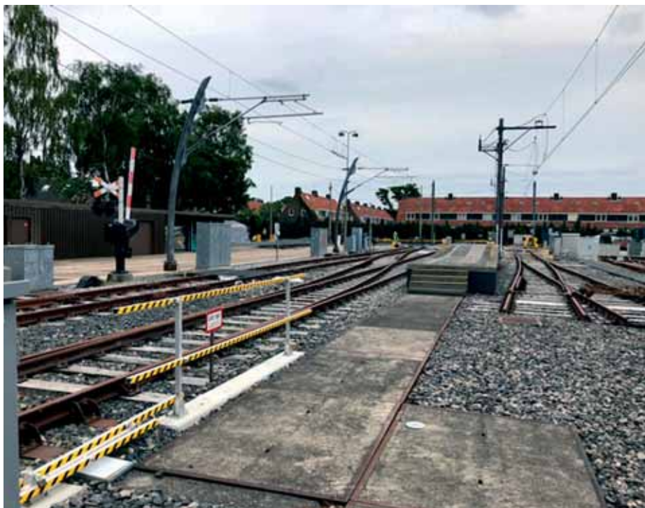
Ispitivanje novog sustava kontaktne mreže
