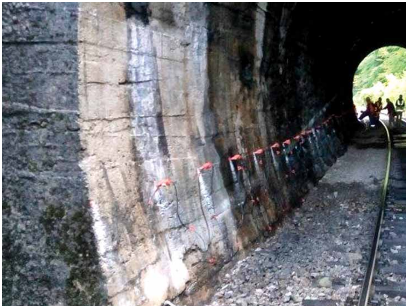
Kontrola strukture tunela SASW i GPR metodom
