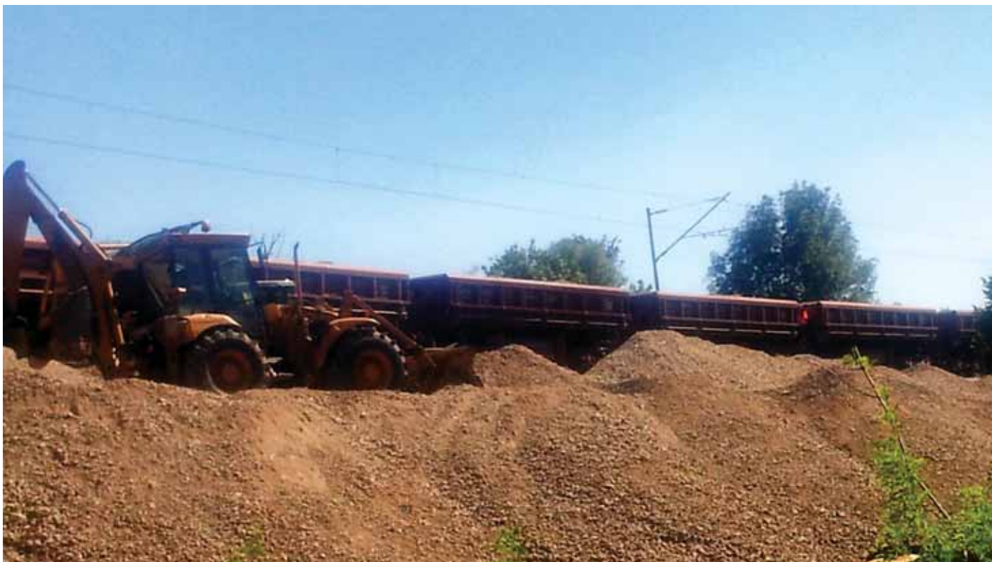
Radovi na sanaciji klizišta Strug
