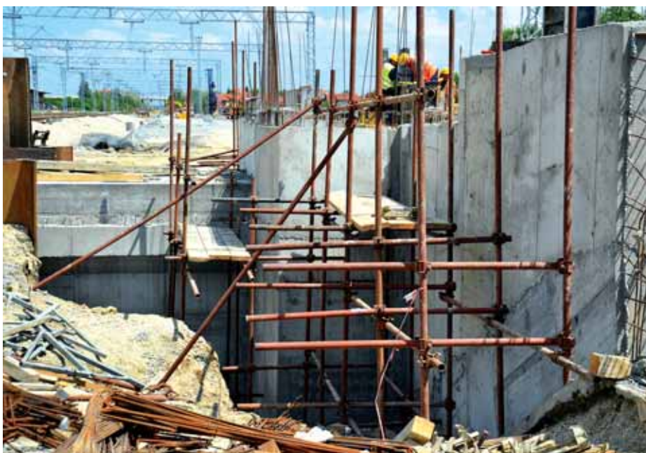
Radovi na pothodniku u kolodvoru Vrbovec
