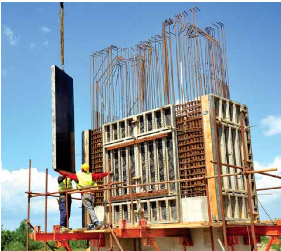
Postavljanje oplata na nadvožnjaku - KR7
