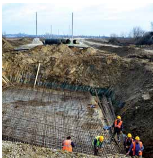
Gradnja mosta na devijaciji
