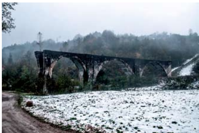
Nedovršeni vijadukt pruga Vrbovsko - Črnomelj
