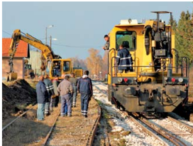
Pružna vozila HŽ Infrastrukture na obnovi pruge u Murskom Središću
