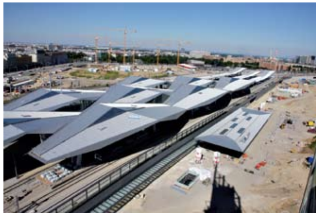
Panorama izgradnje kompleksa Wien Hbf
