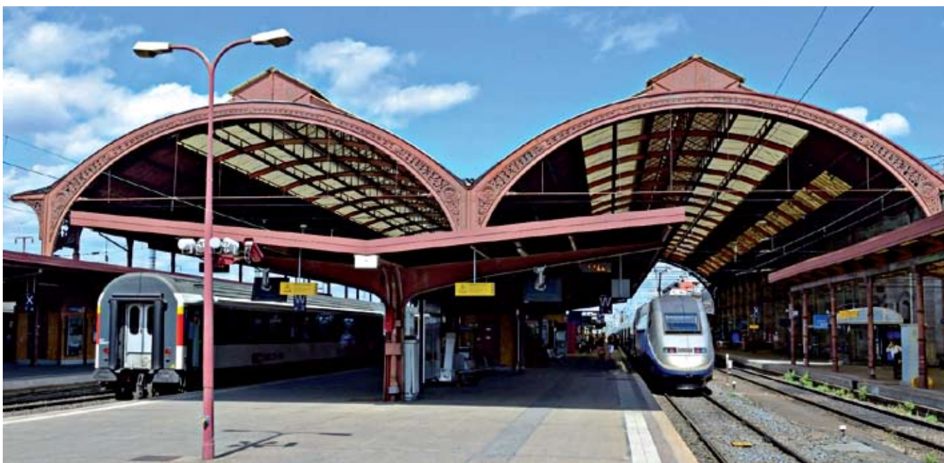
Metalna konstrukcija svoda iznad prva četiri kolosijeka u Strasbourgu po danu
