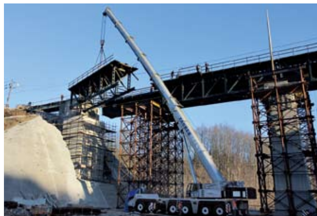
Zamjena konstrukcije mosta, prosinac 2013.
