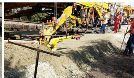
Radovi na obnovi dionice Koprivnica – Botovo – državna granica
