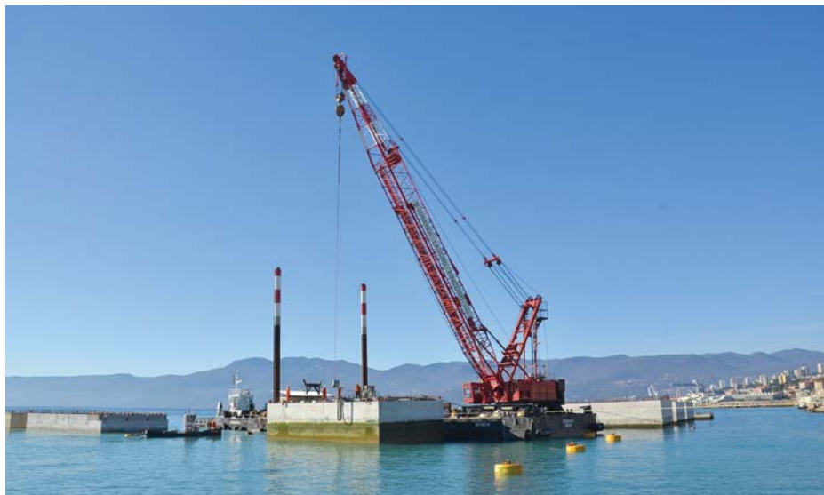
Radovi na izgradnji Zagrebačke obale
