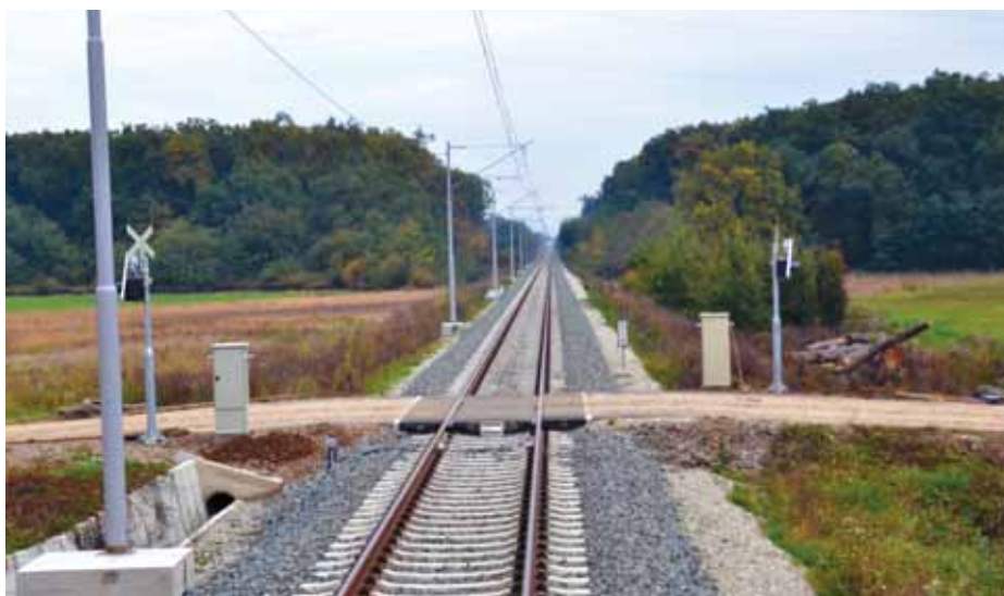
Obnovljena dionica pruge Koprivnica – Botovo – državna granica
