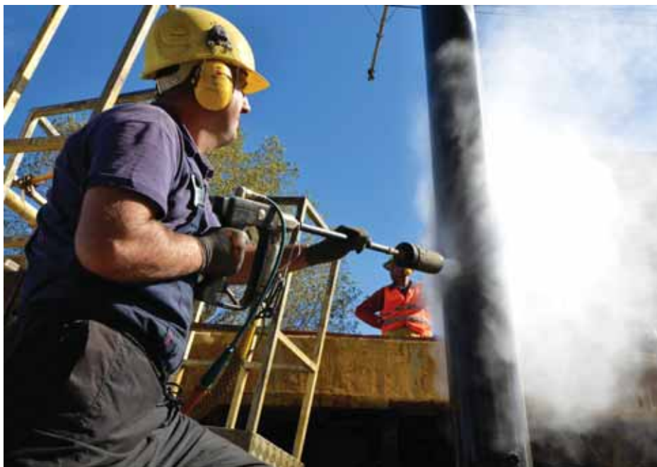
Radovi u kolodvoru Koprivnica
