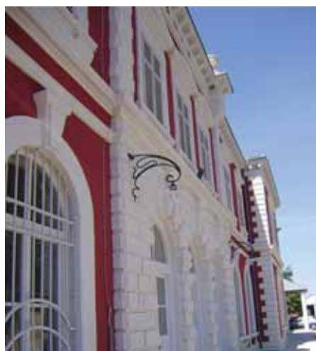
Kolodvor Pula, detalj pročelja
