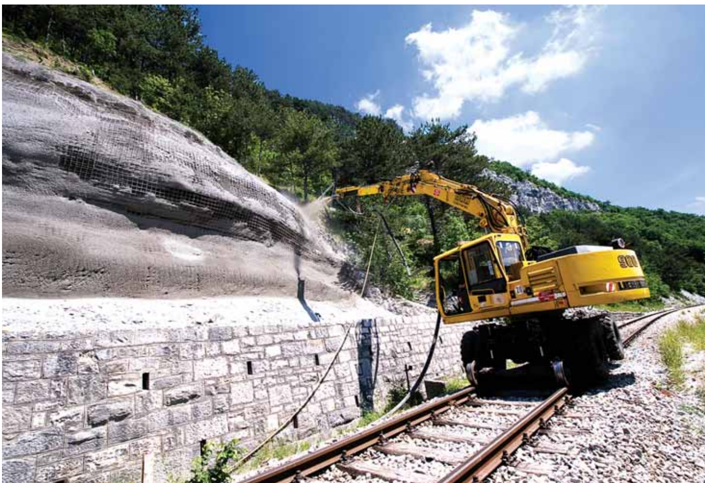
Sanacija Rispadalice, stroj s teleskopskim kranom
