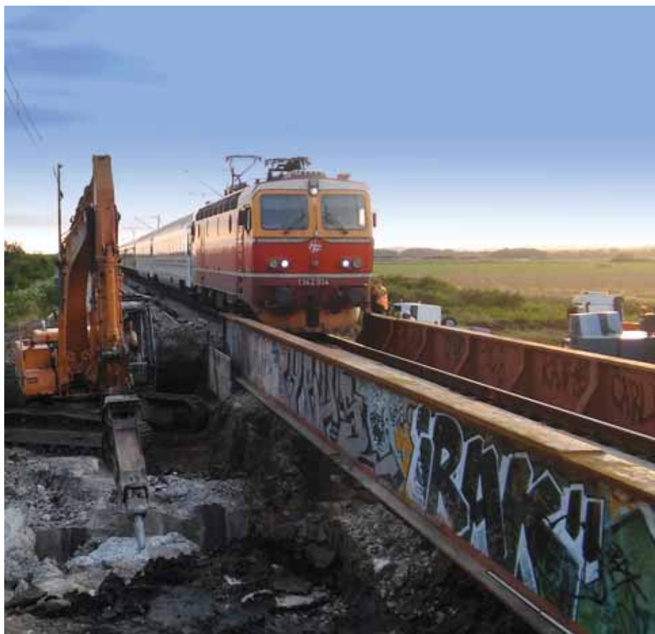
Radovi na propustu kod Nove Gradiške
