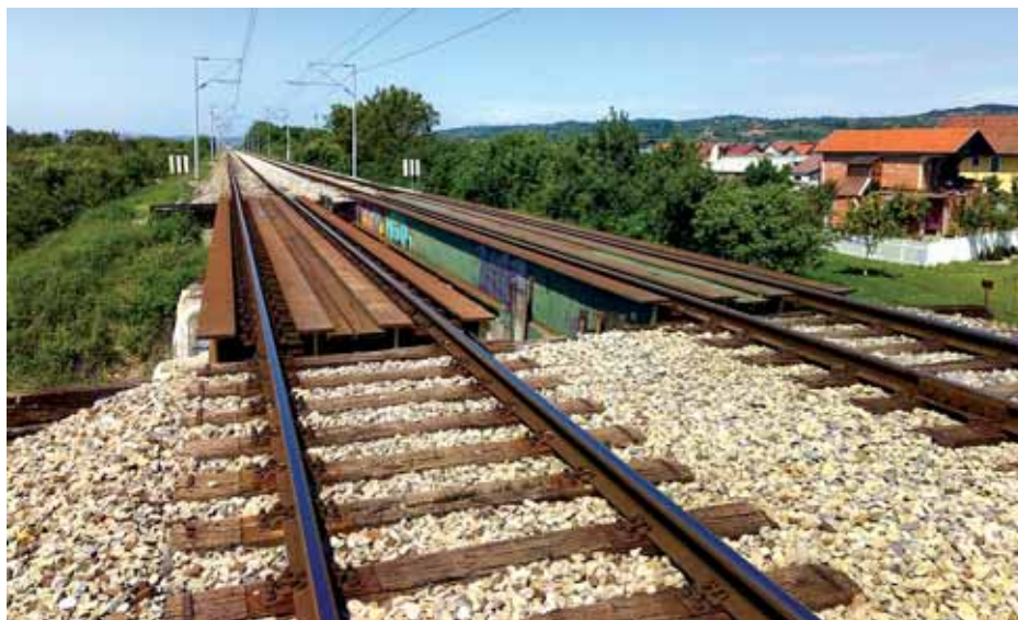
Privremene mosne konstrukcije kod ulaza u Slavonski Brod
