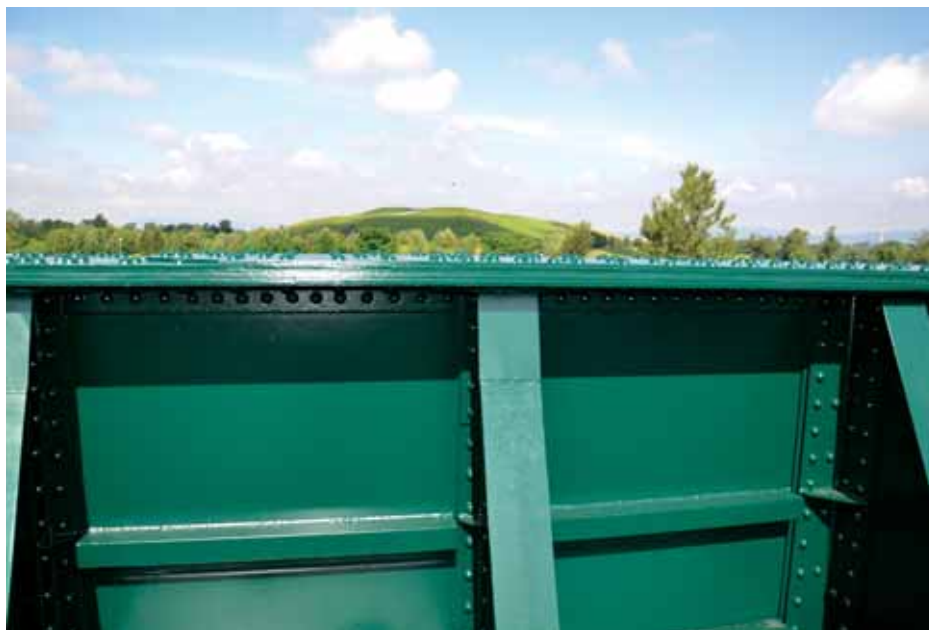
Obnova mosta »Sava Jakuševac«
