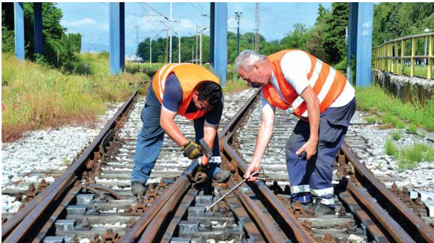
Provjera rada skretnica na zagrebačkom Ranžirnom kolodvoru
