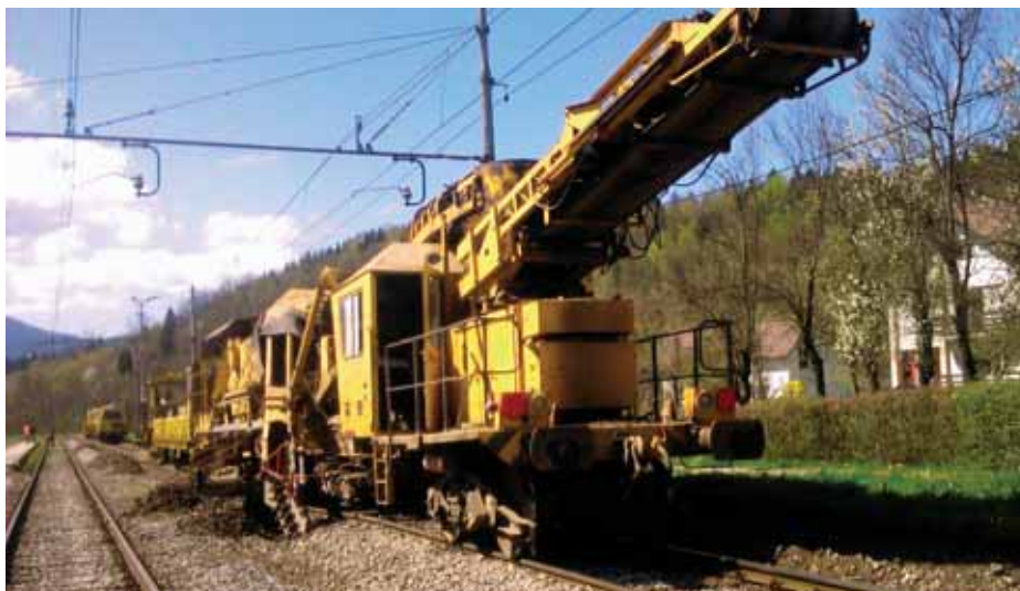
Treći kolosijek kolodvora Gomirje
