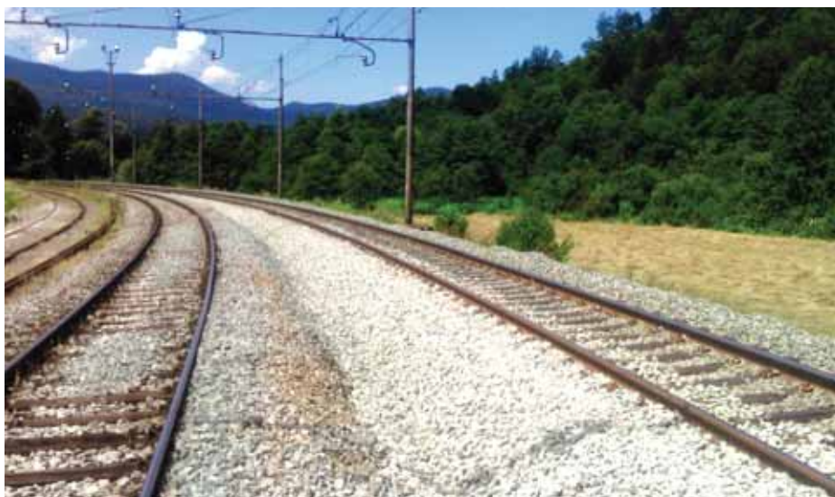
Treći kolosijek kolodvora Gomirje
