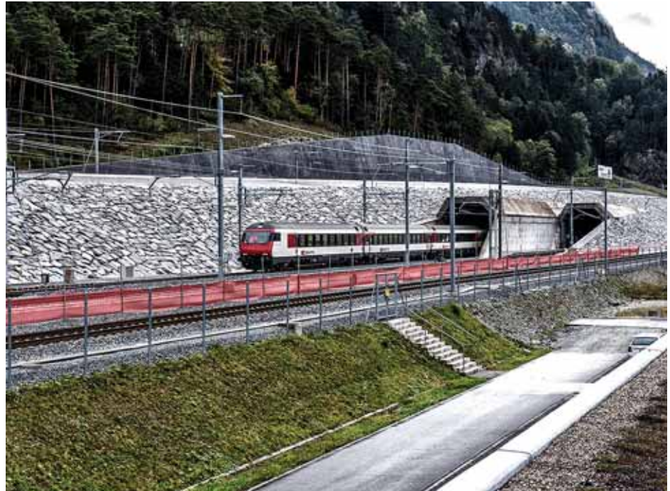
Izlazak vlaka iz sjevernog portala baznog tunela Gotthard, kod mjesta Erstfeld
