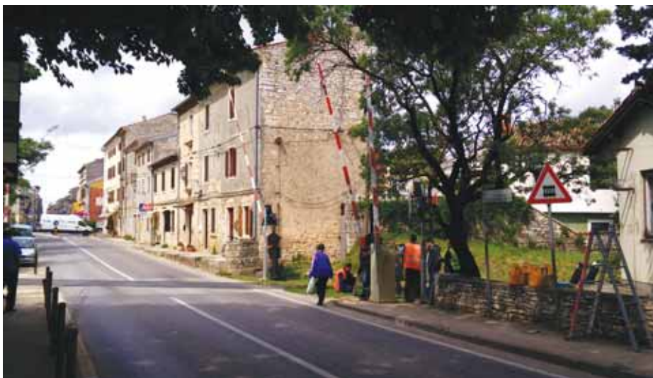
Provjera funkcionalne ispravnosti uređaja na ŽCP-u Vodnjan 1
