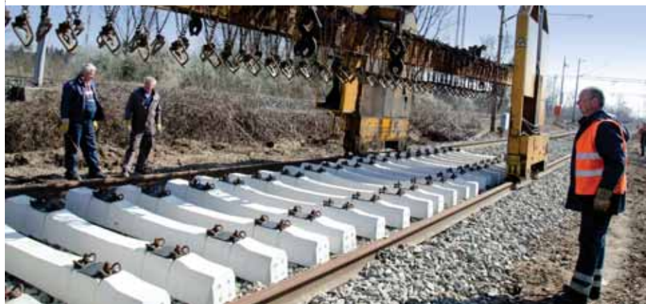
Radovi na rekonstrukciji dionice Zagreb Klara – Delta rasputnica
