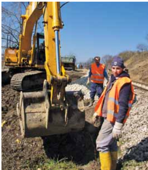
SANACIJA USJEKA I KLIZIŠTA IZMEĐU BUDIŠĆINE I TURČINA
