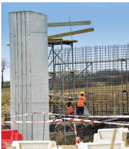
RADOVI NA IZGRADNJI NOVE PRUGE GRADEC - SVETI IVAN ŽABNO
