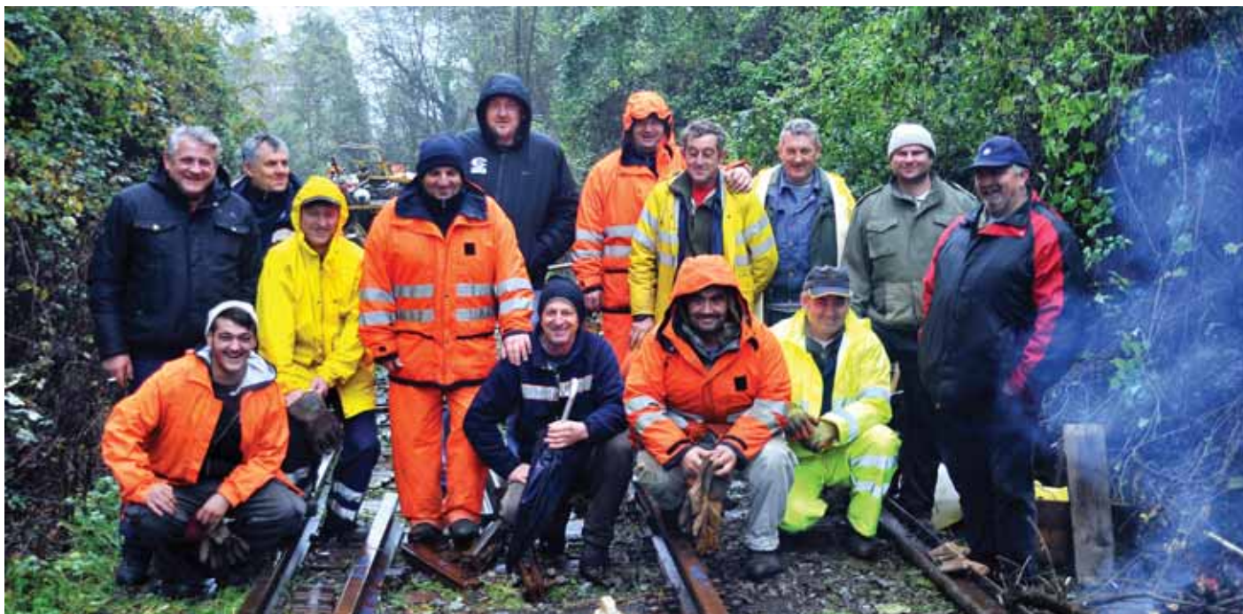
Radnici Pružnih građevina na gradilištu pokraj Đulovca
