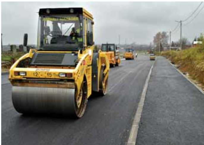
Završni radovi na nadvožnjaku u Vrbovcu
