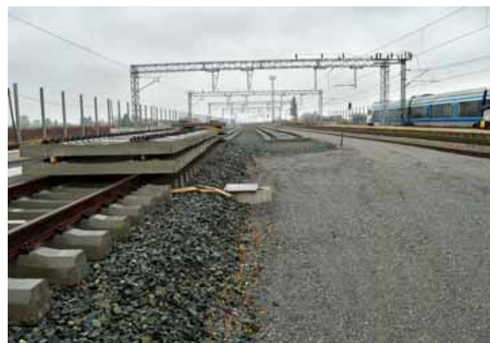
Kolosijek pripremljen za ugradnju
