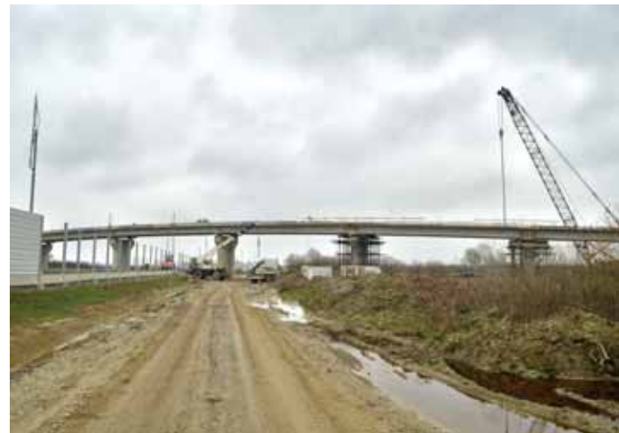
Nadvožnjak ispred kolodvora Vrbovec
