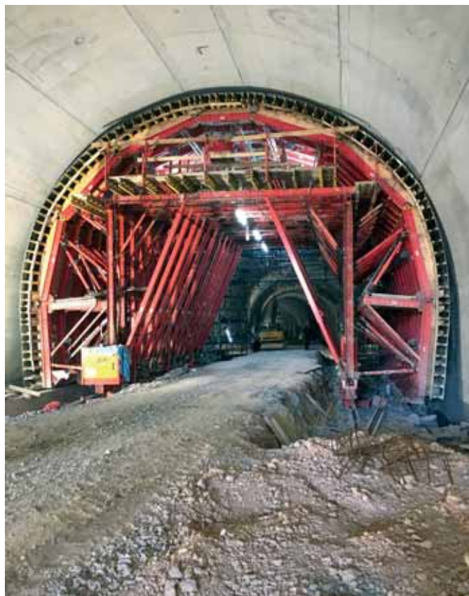
Betoniranje unutrašnjosti tunela
