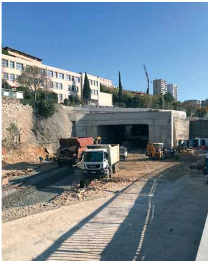
Ulaz u tunel Sušak – portalna građevina
