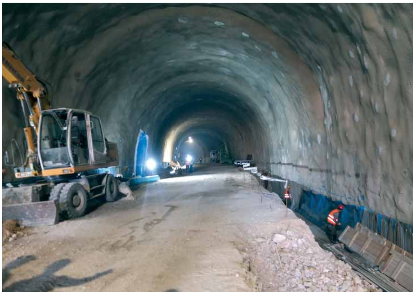
Prošireni dio postojećeg tunela Sušak
