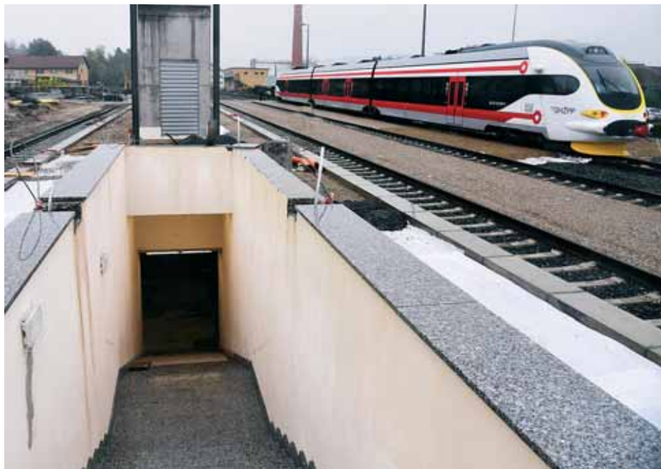
Podhodnik u kolodvoru Zabok
