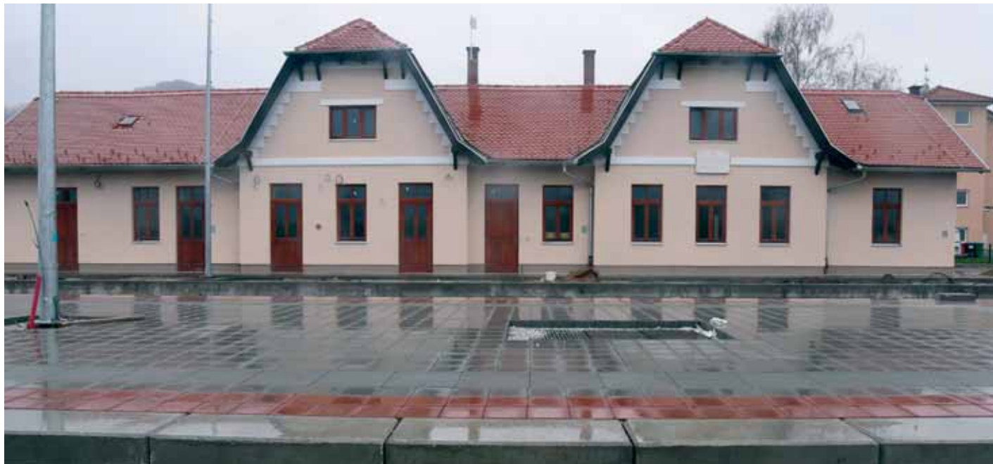
Novi peron i obnovljena zgrada kolodvora Veliko Trgovišće
