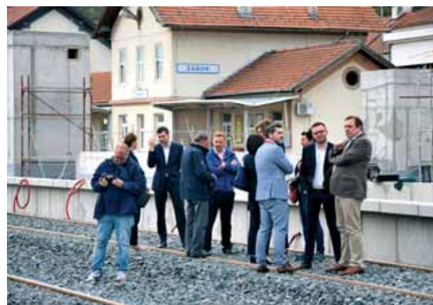
U obilasku radova u kolodvoru Zabok
