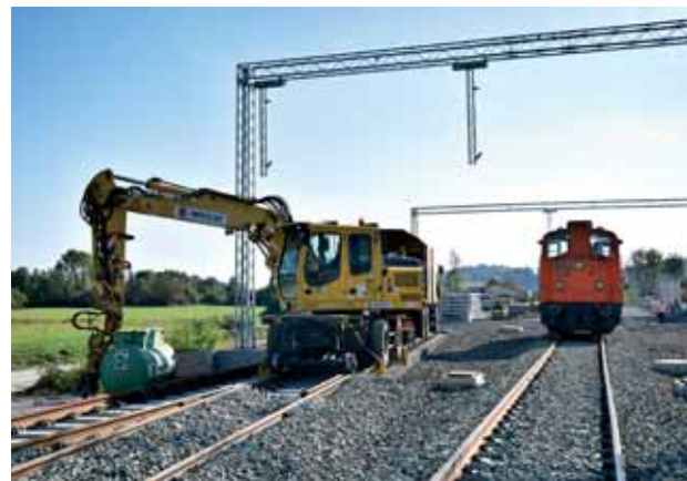
Početkom listopada položena je kolosiječna rešetka duž čitave dionice
