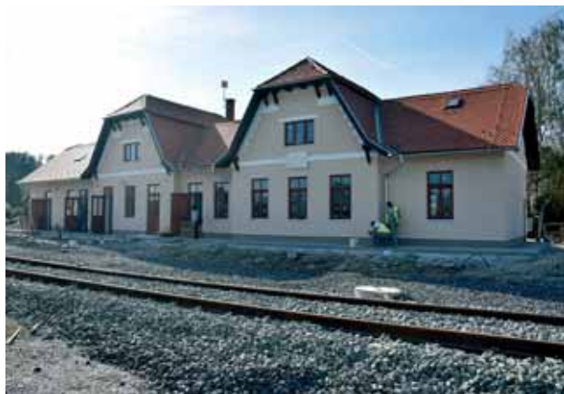
Završni radovi na kolodvorskoj zgradi u Velikom Trgovišću
